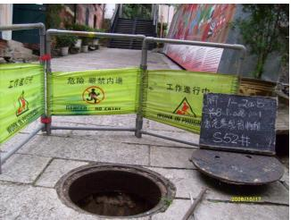
Fig. 1 Open a manhole 圖一. 開沙井
